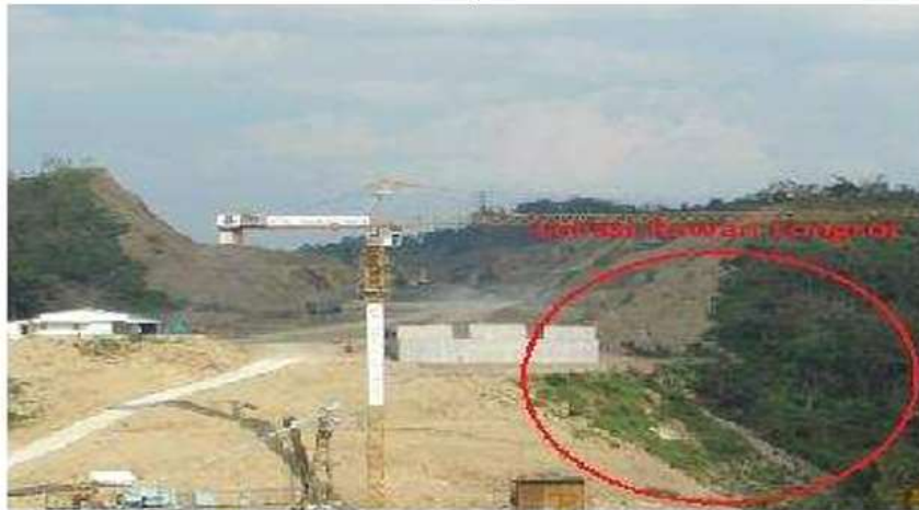
Gambar 1. Lokasi timbunan tanah di sebelah kanan Abutment A2
