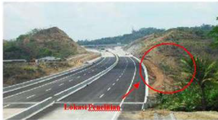
Gambar 2. Lokasi Jembatan Lemah Ireng II Sta.22+125 (Sumber : Dokumentasi di Proyek)
