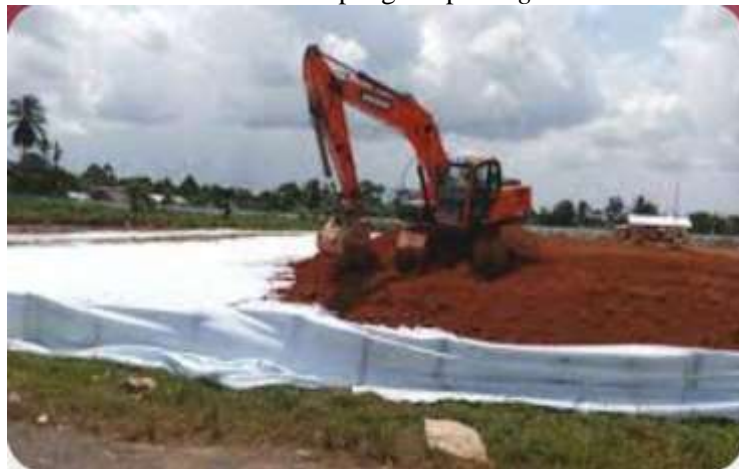
Gambar 3. Proses pemadatan pada tanah urugan
