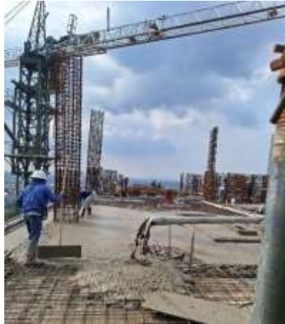
Gambar 1. Kegiatan pengecoran pelat lantai
