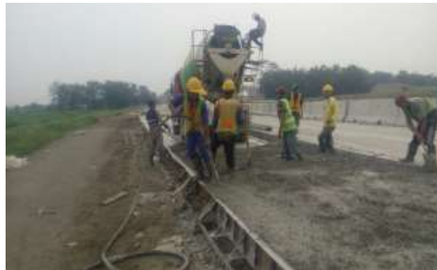
Gambar 2. Proses pengecoran
