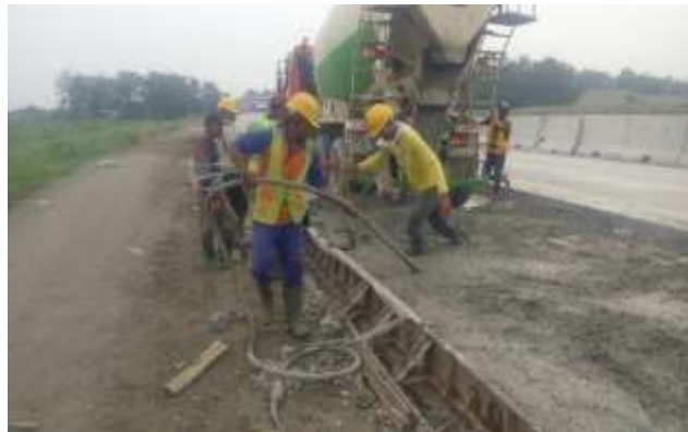
Gambar 3. Pemadatan dengan vibrator
