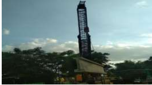
Gambar 2. Peletakan precast gelagar Sumber: Dokumentasi pribadi (2020)
