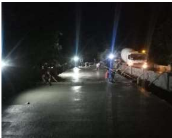
Gambar 4. Pengecoran Plat Lantai Jembatan Sumber: Dokumentasi pribadi (2020)
