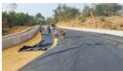
Gambar 1. Pemasangan geotekstil di jalan akses Bendungan X Jawa Barat
