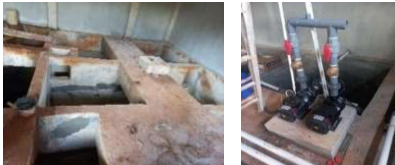
Gambar 3. Bak filter diruang STP Sumber: Dokumentasi Penulis, 2025
