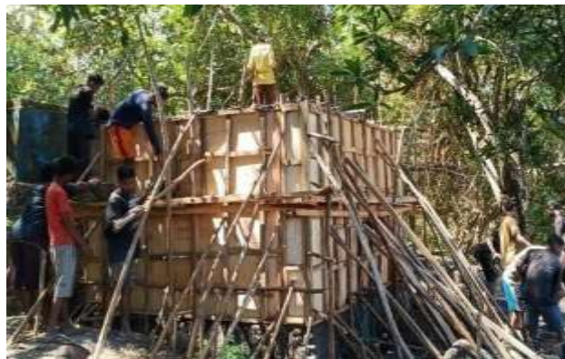
Gambar 2. Pembangunan Reservoir Desa Bandona
